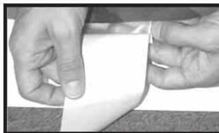
Aplique el filamento de refuerzo
